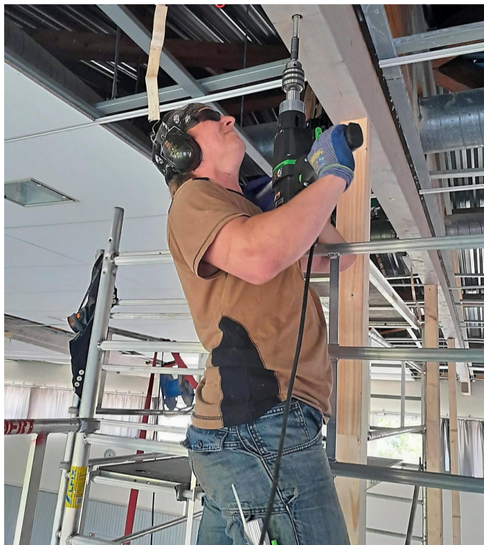
Die Gewindestange wird eingebracht.
